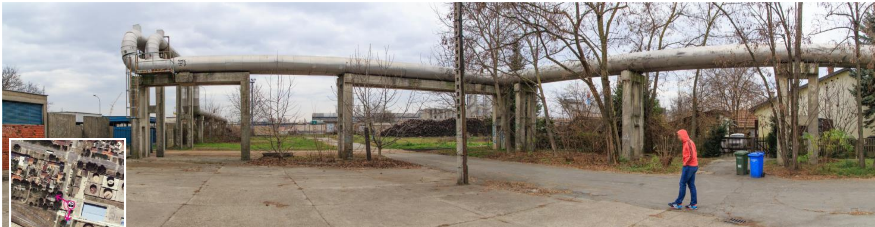
Slika 2-17 Ulica Zeleno polje. Vidljiva postojeća nadzemna struktura vrelovoda predviđena za uklanjanje i izvedbu u podzemnoj varijanti (dionica 2).
