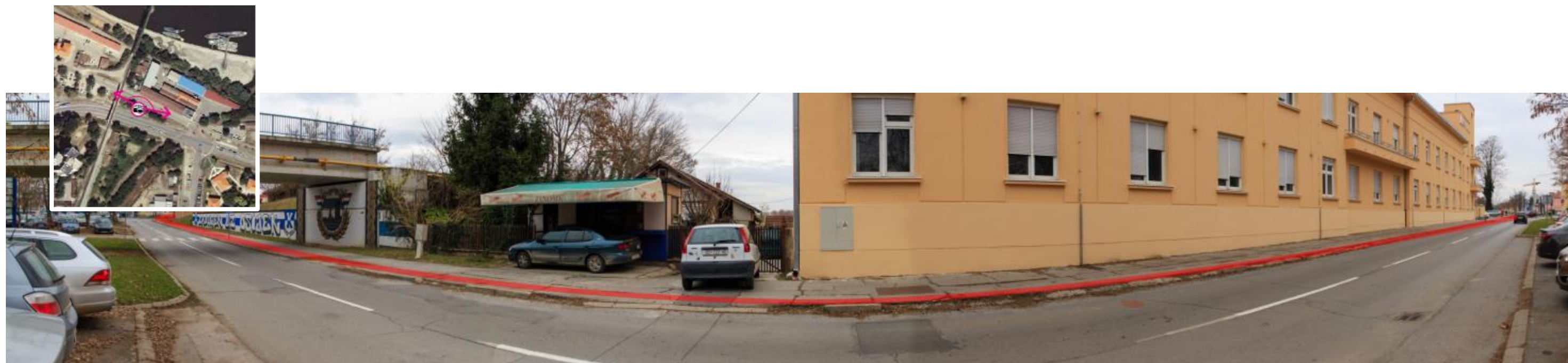
Slika 2-13 Ulica cara Hadrijana, neposredno nakon izlaska vrelovoda iz pogona Osijek - HEP-Toplinarstvo d.o.o.. Trasa podzemnog vrelovoda (dionica 1) označena crvenom bojom.
