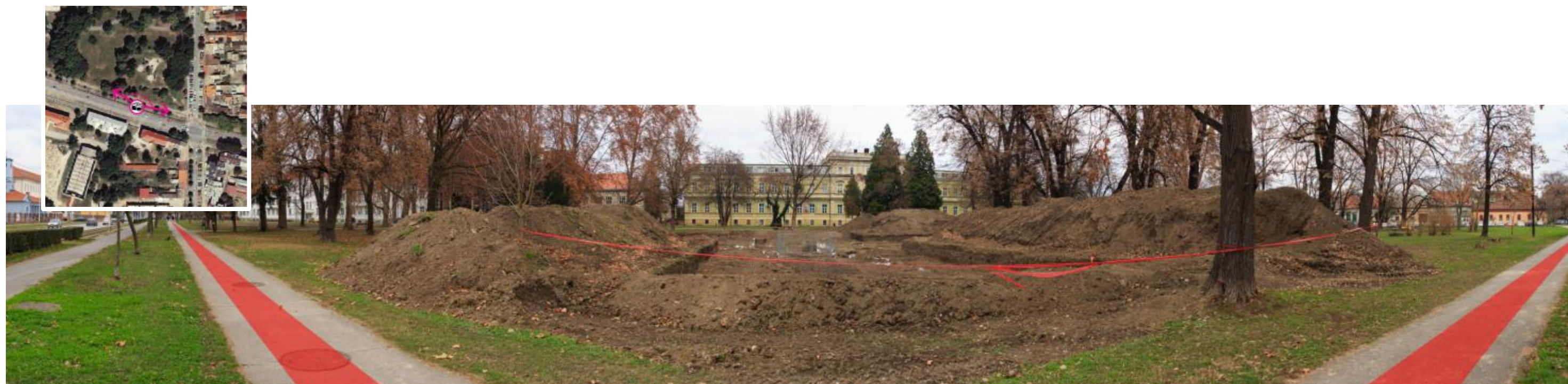
Slika 2-14 Ulica cara Hadrijana, dionica 1, ispred parka kraljice Katarina Kosača. Trasa podzemnog vrelovoda (dionica 1) označena crvenom bojom.
