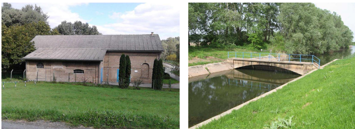
Slika 2.5 Crpna stanica Velika (lijevo) i dovodni kanal crpne stanice (desno) (Izvor: Elaborat revitalizacije)
