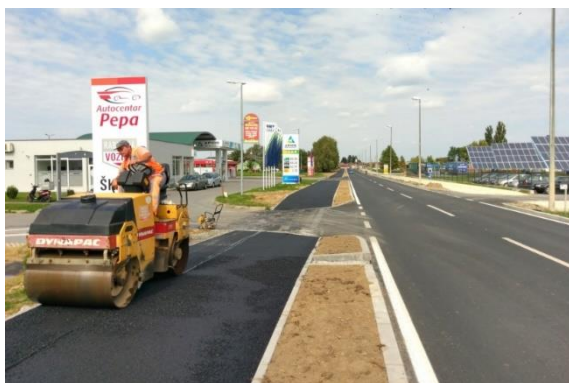
Slika 51: Biciklistička staza u izgradnji, Virovitica
