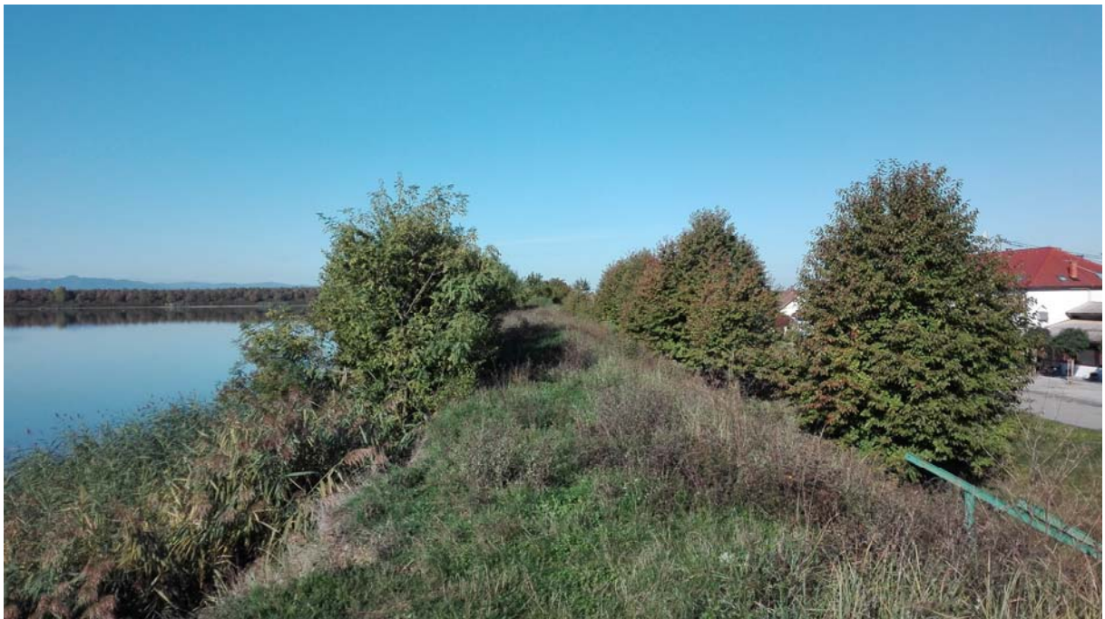
Slika 5. Postojeće stanje nizinske akumulacije Šandor
