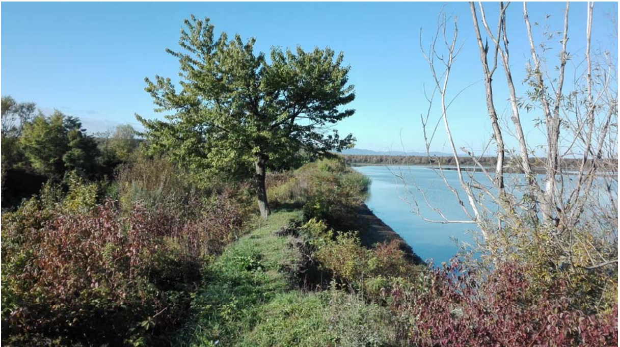
Slika 7. Postojeće stanje nizinske akumulacije Šandor
