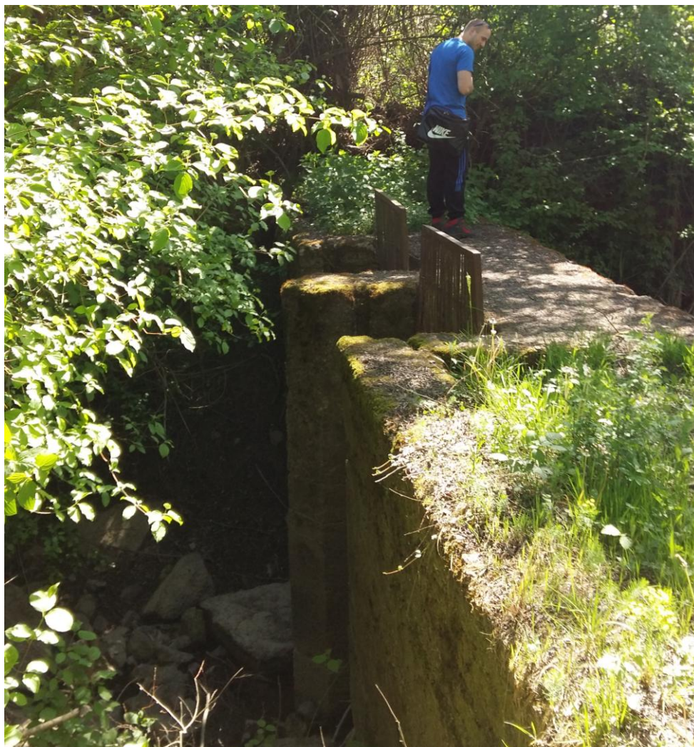
Slika 2-21: Postojeći pločasti propust
