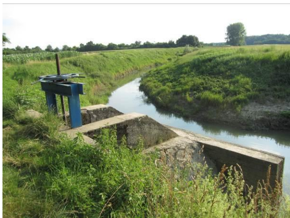
Slika 2-10 Lokacija ustave Kapelna na rkm 54+122 Karašice
