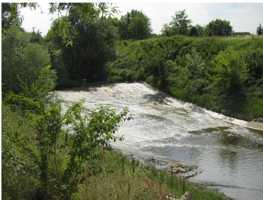
Slika 2-14 Lokacija praga na Gatskom kanalu
