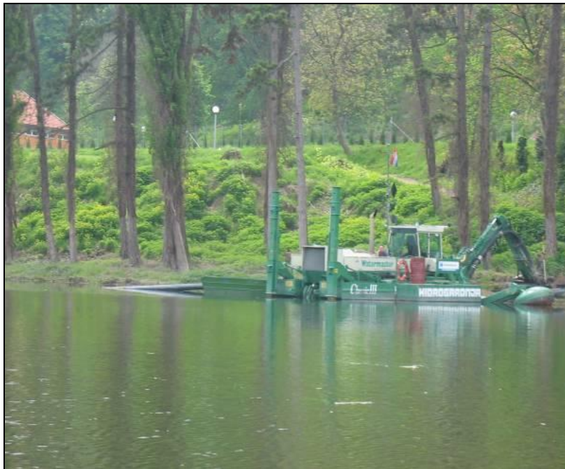
Slika 2.4-6. Izmuljivanje refuliranjem
