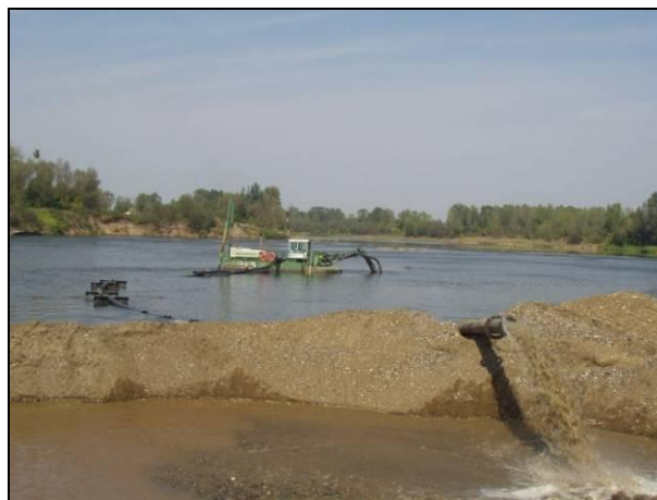
Slika 2-10 Refuliranje plovnim bagerom pod obalu (foto: AVP).
