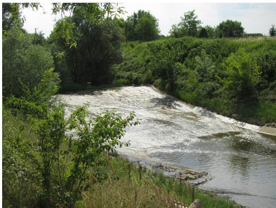
Slika 2-14 Lokacija praga na Gatskom kanalu
