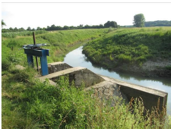
Slika 2-10 Lokacija ustave Kapelna na rkm 54+122 Karašice
