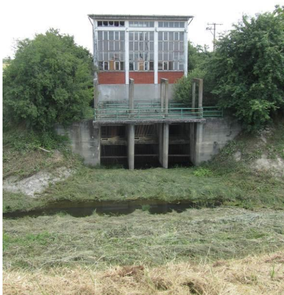
Slika 2-7 Postojeća crpna stanica Krnjak
