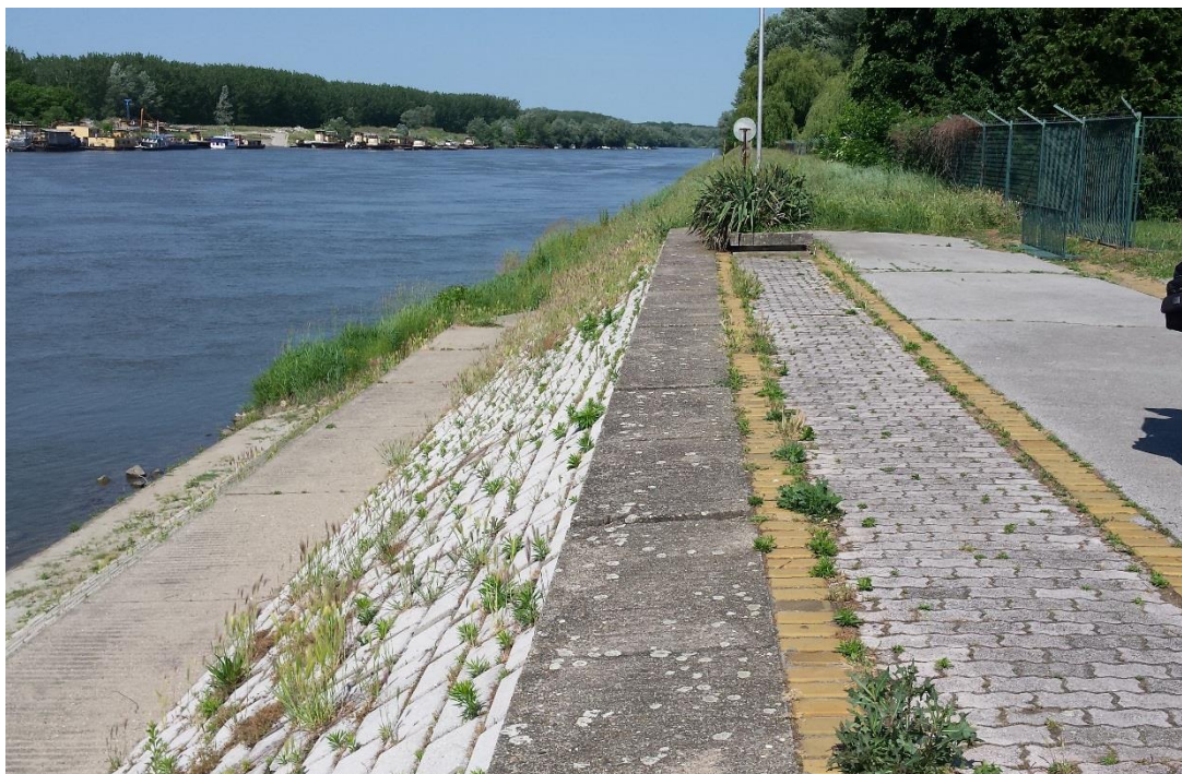
Slika 2.3 Spoj postojeće obaloutvrde i potez buduće dogradene obaloutvrde od rkm 22+211 do 22+690 (izvor: Idejno rješenje, Brodska posavina d.d.)
