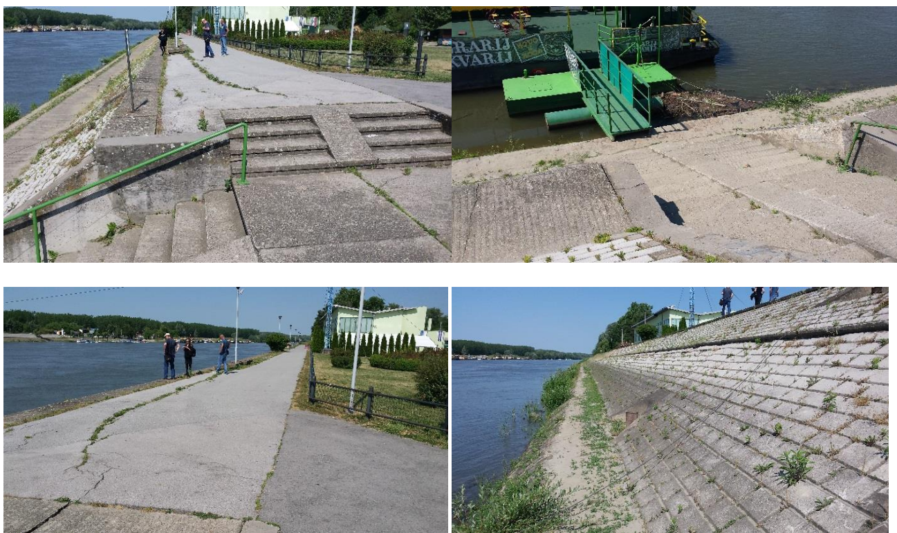
Slika 2.1 Prikaz stanja postojeće obaloutvrde (izvor: Idejno rješenje, Brodska posavina d.d.)
