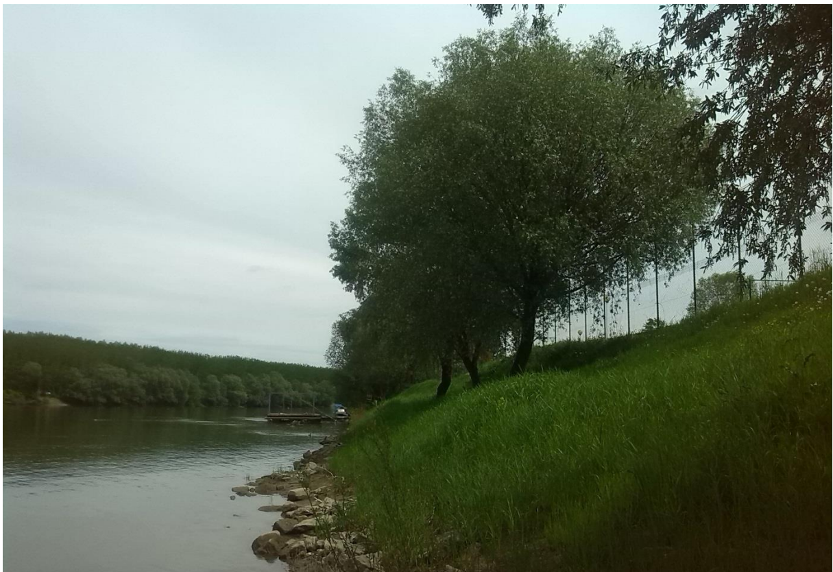
Slika 3.2: Postojeće stanje desne obale rijeke Drave uz kompleks vojarne Vrbik
