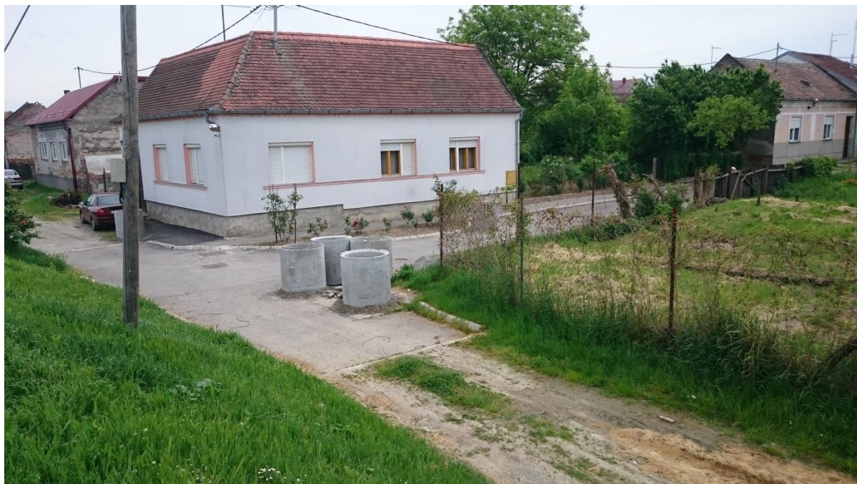
Slika 3.4: Improvizirani upojni zdenci za evakuaciju procijednih voda na lokaciji Donji grad
