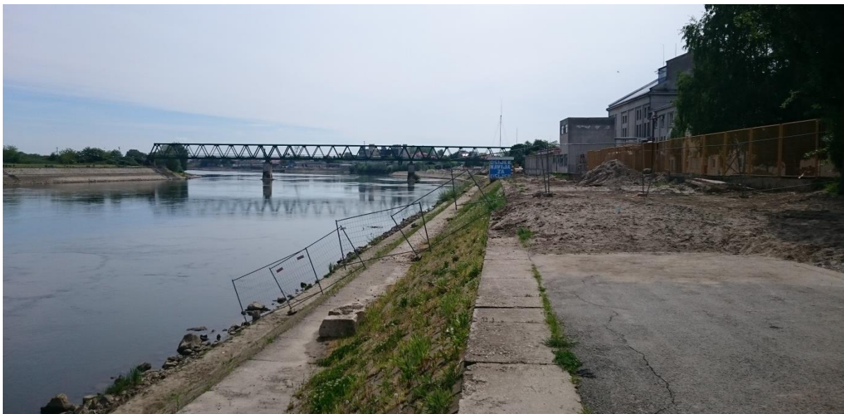
Slika 3.8: Pogled sa lokacije cestovnog mosta prema željezničkom mostu
