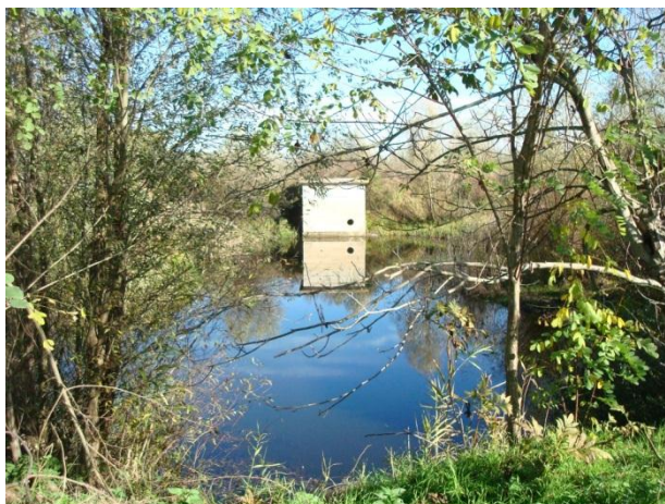
Slika 2.3 Objekt crpne stanice
