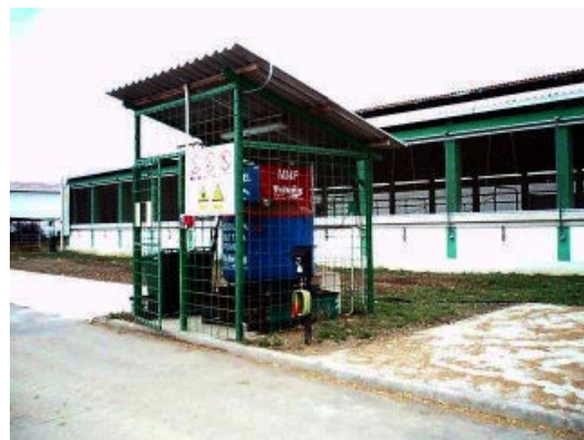
Slika 9. Skladište opasnog otpada
