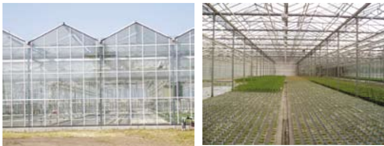
Slika 38 a i b: Suvremeni staklenici, proizvodna visina 4.5 m (snimila Paradiković, N.)
