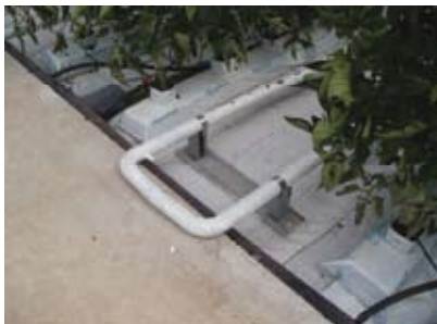
Slika 19 a i b: Cijevni razvod toplovodnog grijanja (lijevo) i podno grijanje (desno) (snimila Parađiković, N.)
