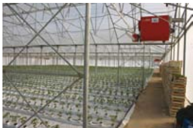
Slika 17: Samostalna jedinica za zagrijavanje toplim zrakom loživim uljem (snimila Parađiković, N.)
