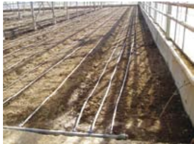
Slika 80 a i b: Polaganje sustava za navodnjavanje i polaganje folije (snimila Paradiković, N.)
