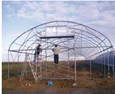
Slika 4 a, b, c i d: Montaža plastenika (snimila Drventić, V.)
