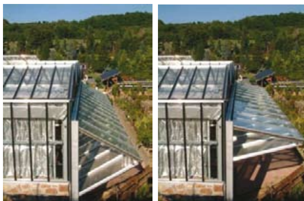
Slika 44 a i b: Bočna ventilacija (arhiva Siedenburger)
