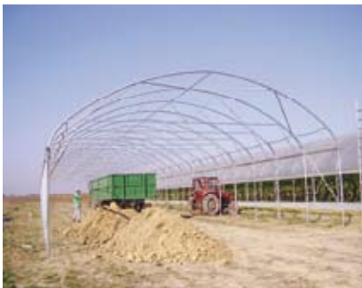
Slika 4 a, b, c i d: Montaža plastenika (snimila Drventić, V.)
