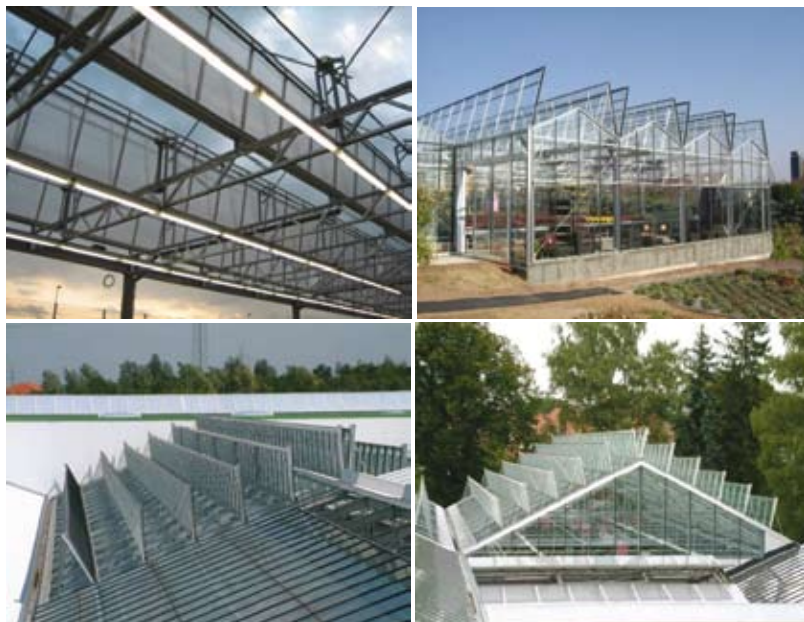
Slika 43 a, b, c i d: Mogućnosti otvaranja krovne ventilacije staklenika (arhiva Siedenburger )
